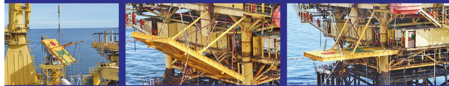
Planta de proceso - RENOVA - Rosario
